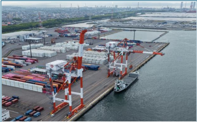
インバーター制御方式のガントリークレーンの導入 (全2基)
