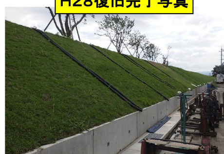
H28復旧完了写真
