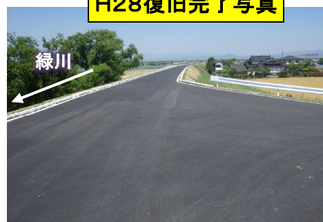
H28復旧完了写真
