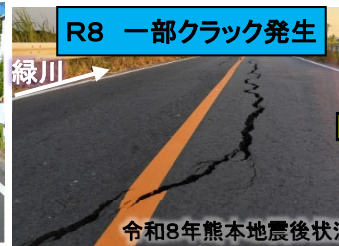
令和8年熊本地震後状況 大部分の区間では変状なし 一部区間で天端クラック発生
