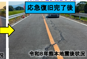
令和8年熊本地震後状況 大部分の区間では変状なし 一部区間で天端クラック発生
