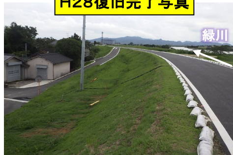
H28復旧完了写真
