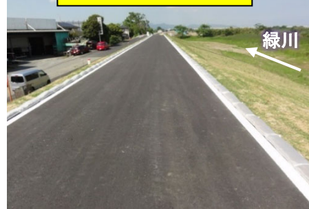
H28復旧完了写真
