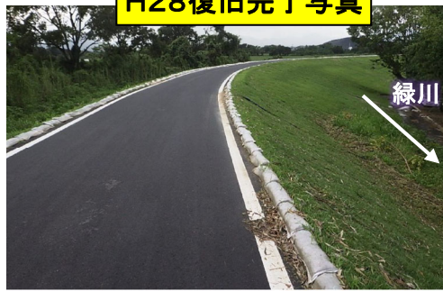
H28復旧完了写真
