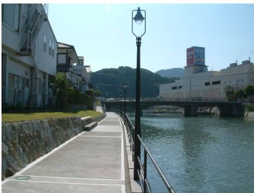
●施工後の遊歩道
