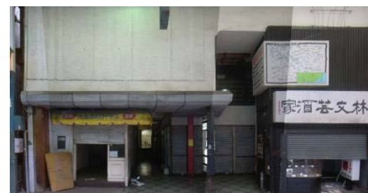
空き店舗(改装前)
