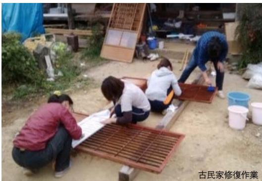
古民家修復作業 出典)対馬市
