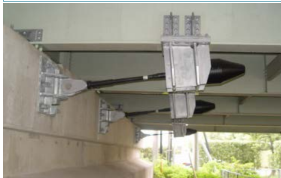
落橋防止装置の設置
