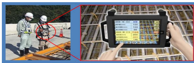
対象物を撮影 検査結果（判定結果＋計測値） デジタル配筋検査（試行）
