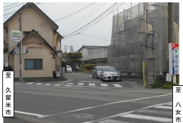
【整備前状況写真】
