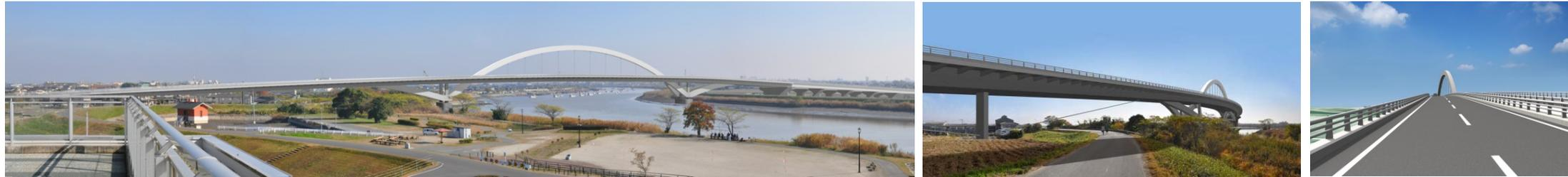
張弦梁構造では桁高を抑えることはできない（たわみNG）。桁下にケーブルが配置されるため煩雑な印象となる。
