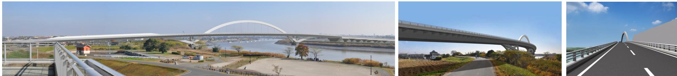
遠景からの視点では桁と補剛部材が6mを越える壁として見える。内景観においても眺望が大きく阻害される。
