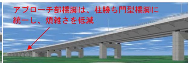
桁の段差を視認しにくい壁式橋脚とし煩雑な印象を解消
