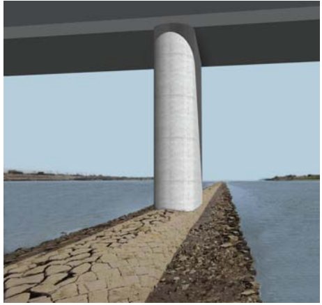
鋼アーチ橋の橋脚幅 (4.5m)
