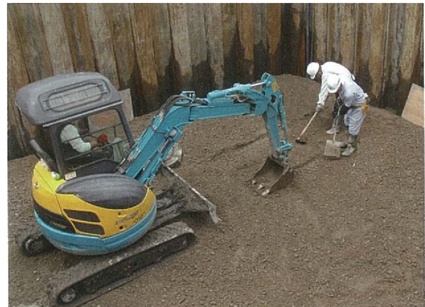
小型BH及び人力による施工例
