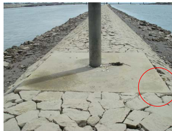
充填していない境界部
