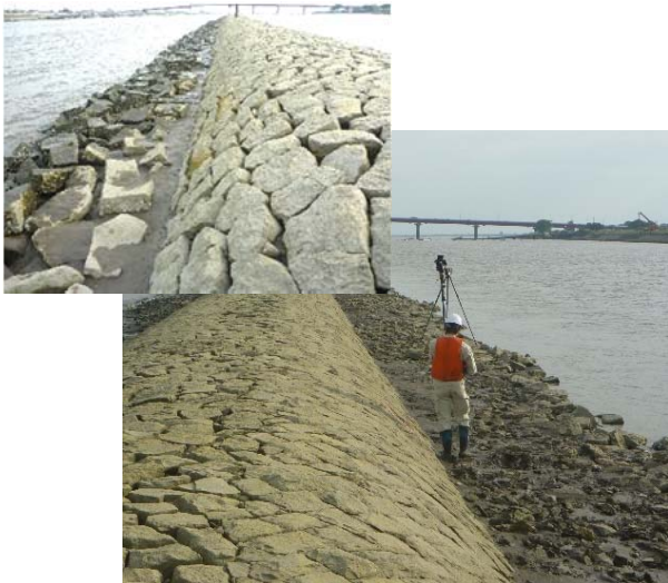
解体移設場所の状況
