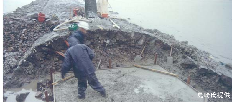
平成4年ごろの工事の様子
