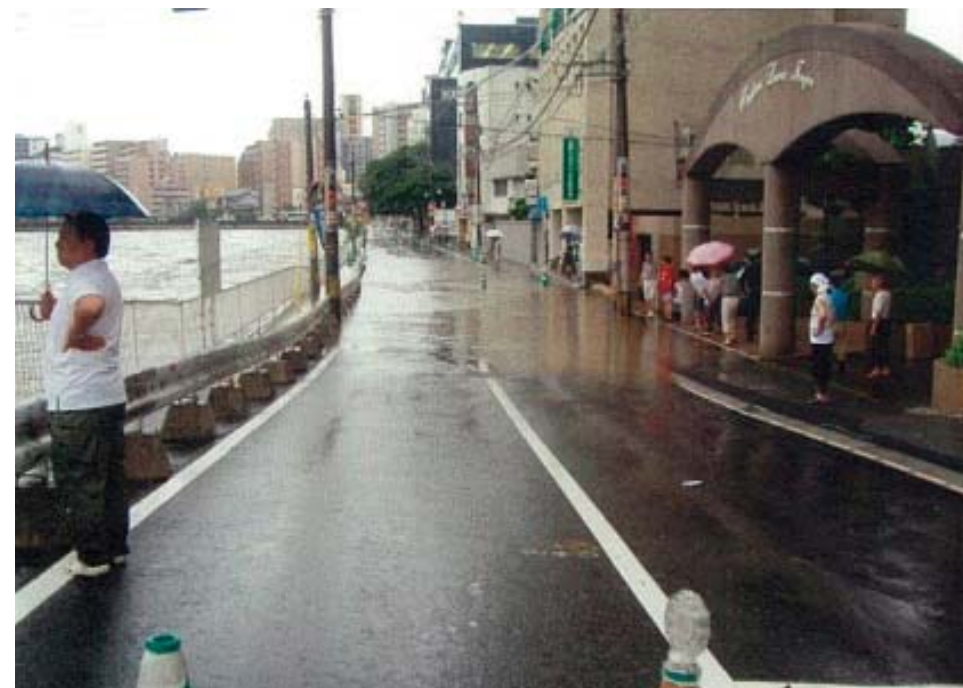
春吉橋周辺の道路の冠水状況(平成21年7月26日) (住吉橋左岸より上流側を望む)
