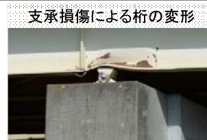
写真-5 九州自動車道 （木山川橋）
