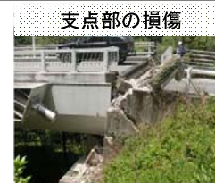
写真-6 熊本高森線 （桑鶴大橋）
