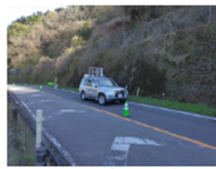
MMS※1を活用した斜面・のり面点検
