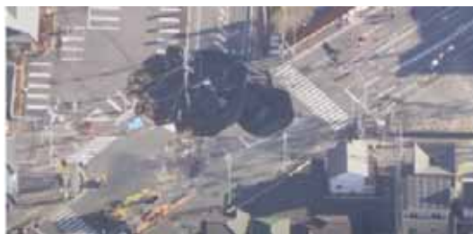
下水道等に起因する大規模な道路陥没事故を踏まえた対策検討委員会(第1回)資料抜粋
