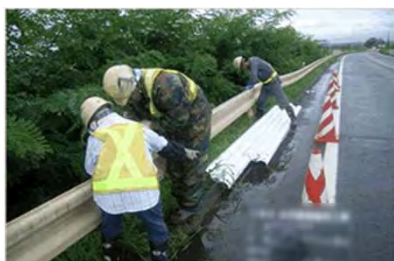
<防護柵の取替>
