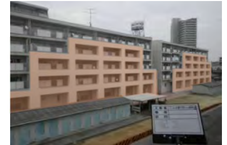
▲外付けフレーム耐震補強
