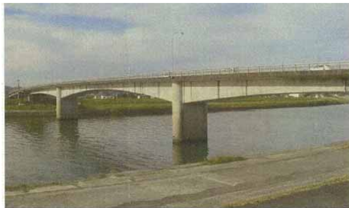
▲天大橋全景写真
