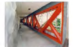
鉄骨ブレースによる壁の補強
