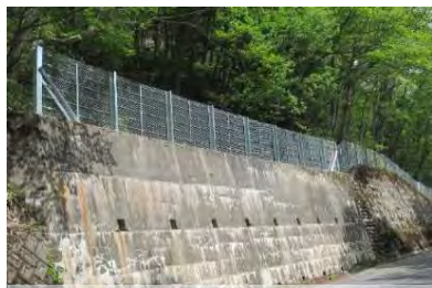
<落石防止柵の取替>
