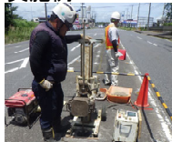
(貫入試験による調査)
