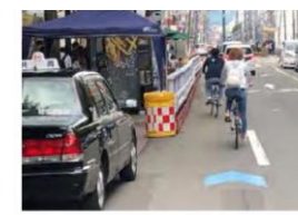
矢羽根型路面表示の設置
