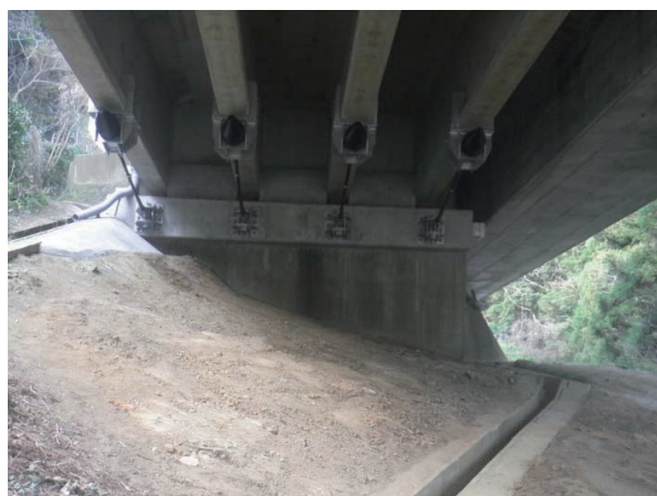
▲耐震補強(落橋防止)
