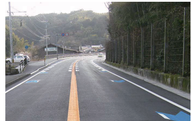
▲国道3号 下辺春地区(八女市)
