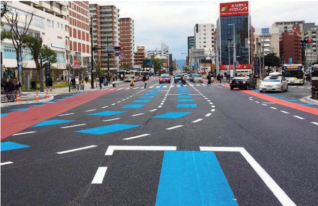
▲国道202号 六本松交差点(福岡市)
