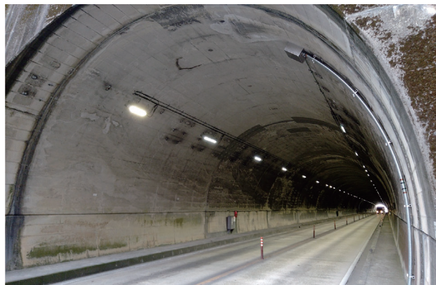
▲国道202号 甲ノ峯トンネル(糸島市)
