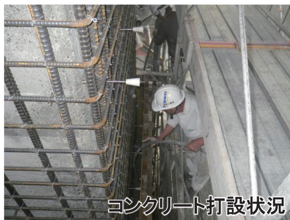
▲耐震補強(柱部コンクリート巻立)
