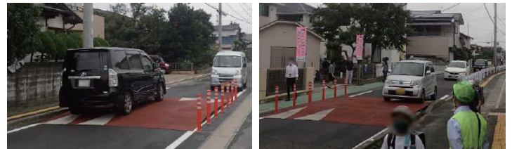
▲ 実証実験(可搬型ハンブを設置)(古賀市)
