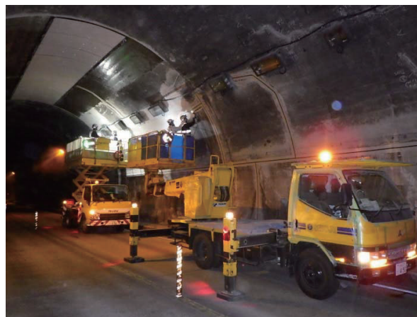
▲立花トンネル補修
