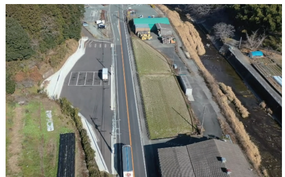
▲道の駅「うきは」・防災広場：平成29年12月完成
