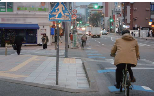
▲国道202号国体道路での整備事例(車道混在)
