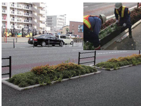
▲植栽ユニットによる施工性の向上
