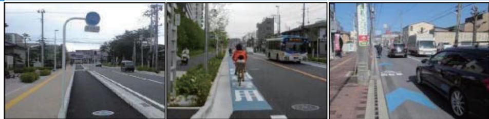
▲交通状況による整備形態の違い
