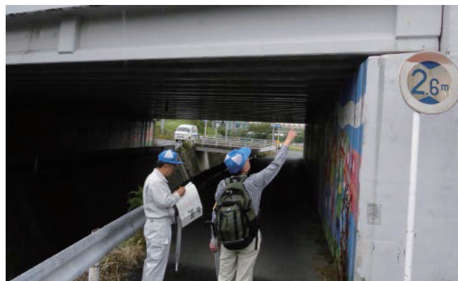
事務所退職者からなる「福岡橋守マイスター会」の協力で、橋梁損傷や不具合を早期発見
