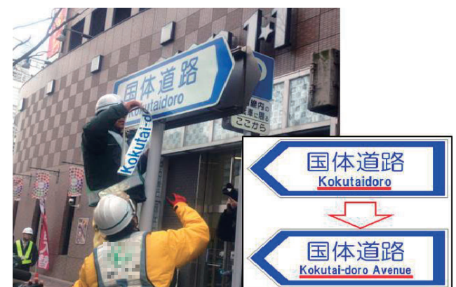
▲国道202号 国体道路(福岡市)
