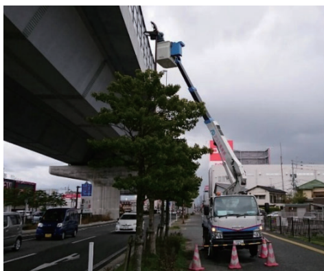
▲照明灯維持管理
