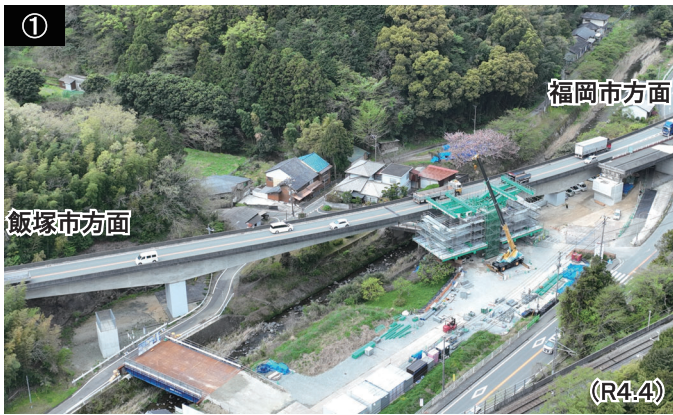
▲筑前山手橋 工事状況
