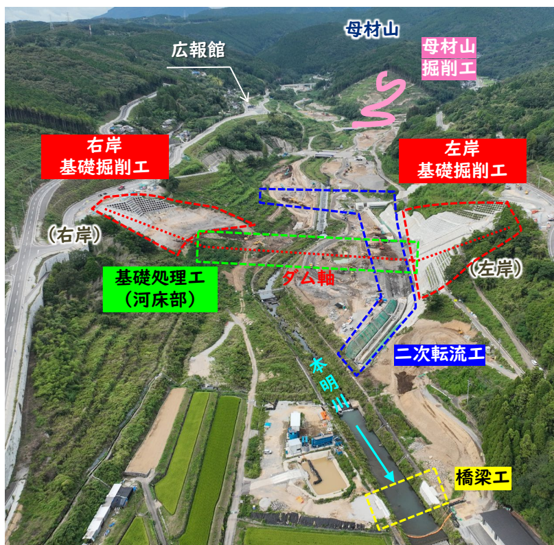
工事進捗状況（R8年9月18日時点）
