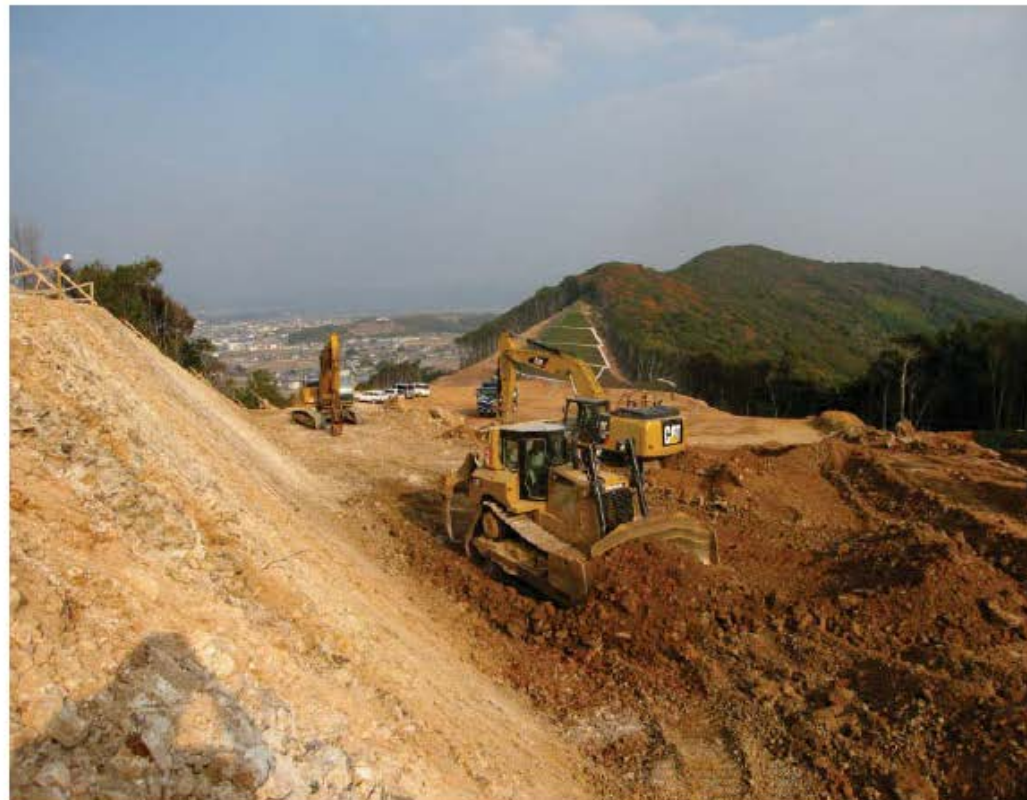
掘削(切土)施工中
