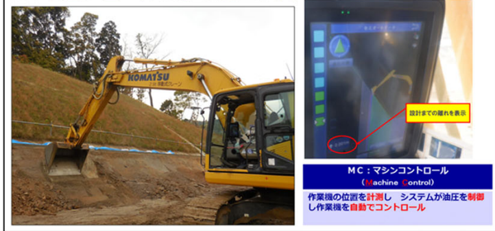
ICT油圧ショベルによる施工状況
