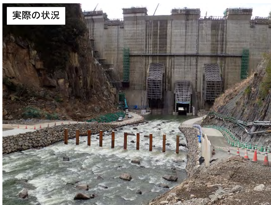
図 2.3.1.(10)-4 統合モデルと実際の状況（流木等捕捉工）
