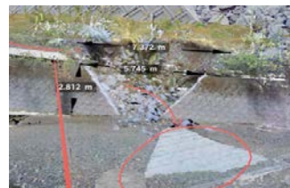
被災状況3次元モデル化の事例
