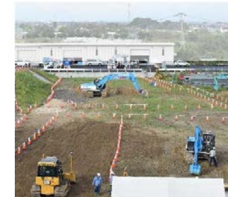
野外フィールドにおけるICT建機・ 遠隔操作訓練
