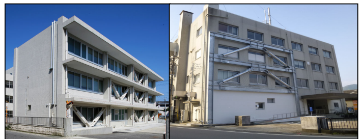
鹿児島地方裁判所名瀬支部 【平成24年度 耐震改修済】
