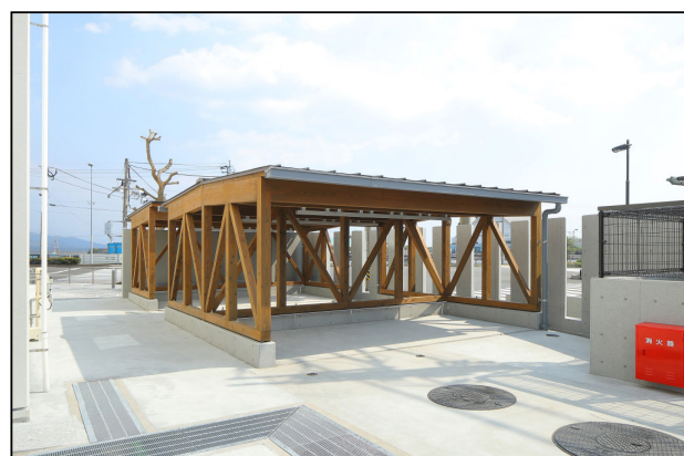
鹿児島港湾合同庁舎（駐輪場に木材を利用） 【平成31年度完成】
