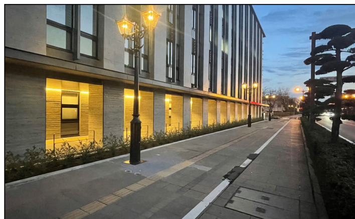
鹿児島第三地方合同庁舎 ガス灯点灯時
