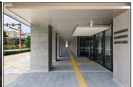
鹿児島第三地方合同庁舎 （歩道より段差なくアクセス） 【令和5年度完成】
