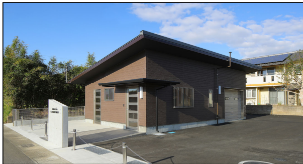
宮之城森林事務所（木造庁舎として整備） 【令和3年度完成】
