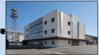
延岡労働総合庁舎 (令和4(2022)年度完成)
