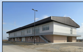
鹿児島海上保安部船艇用品庫 (令和2(2020)年度完成)
