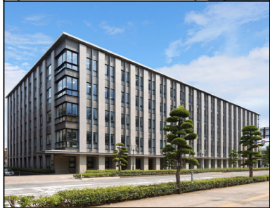
鹿児島第三地方合同庁舎 （縦ルーバーによる 西日カット） 【令和5年度完成】
