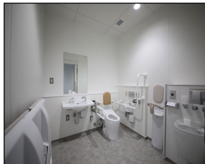
延岡労働総合庁舎 （多機能便所） 【令和4年度完成】
