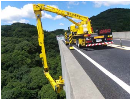
▲橋梁点検車による点検状況
