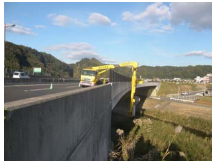
▲橋梁点検車による点検状況
