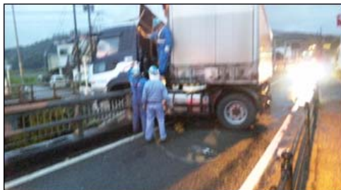
高欄を突き破って停車し、橋梁(下り)を封鎖
