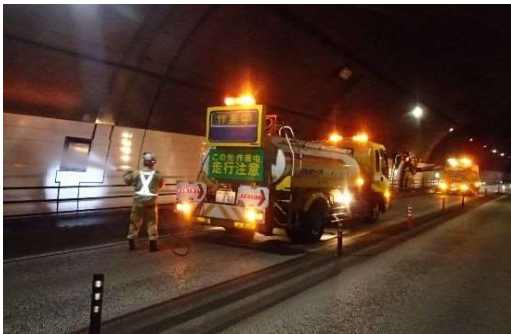
トンネル清掃
