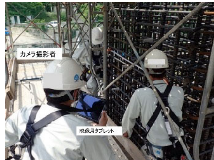
①臨場(受注者)の状況
