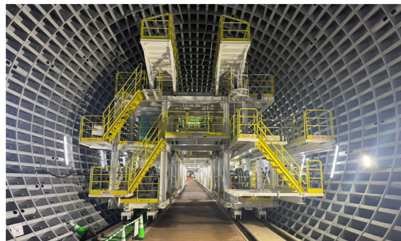
坑内に配置した後続台車（6台目）
