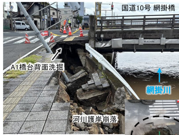
写真② 【上流側護岸の被災状況】
