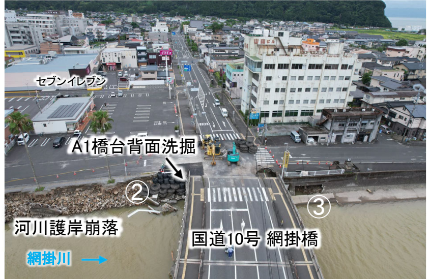
写真② 【上流側護岸の被災状況】
