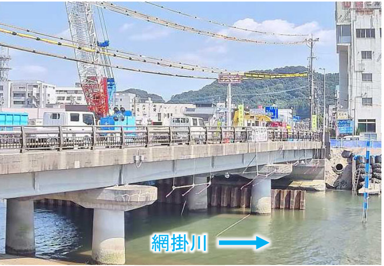
鋼矢板打設状況【下流側より】 (10/7 13:00撮影)
