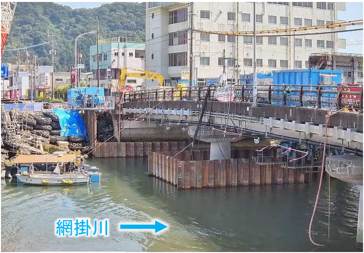
鋼矢板打設状況【上流側より】 (10/7 13:00撮影)
