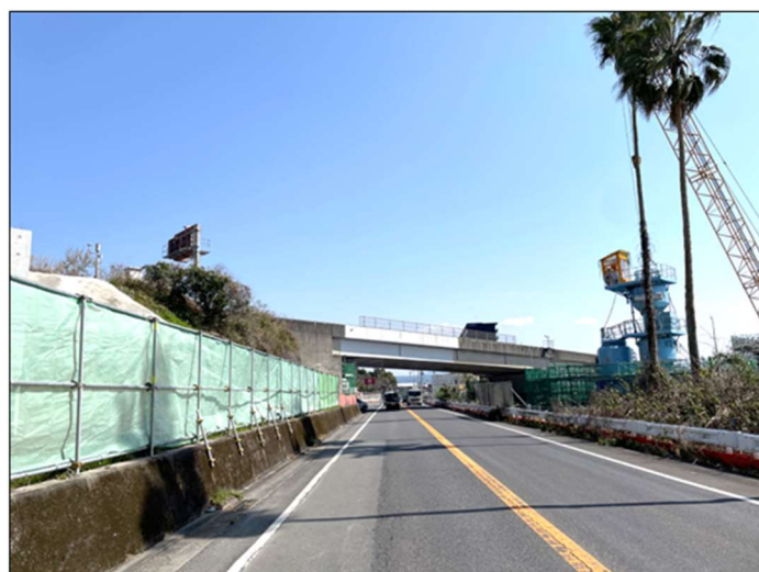
橋梁架設予定箇所
