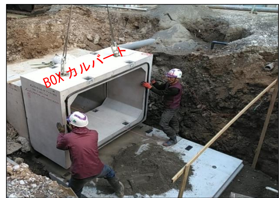
【BOXカルバート施工状況 イメージ写真】
