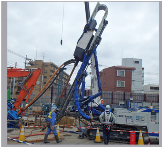
斜め施工用の地盤改良機の例
