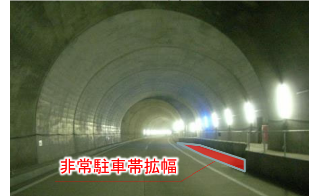
トンネル内非常駐車帯拡幅
