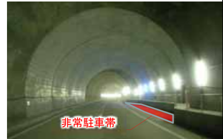
トンネル内非常駐車帯
