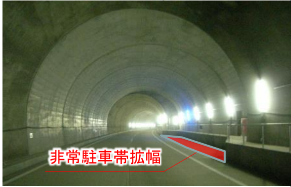
トンネル内非常駐車帯拡幅
