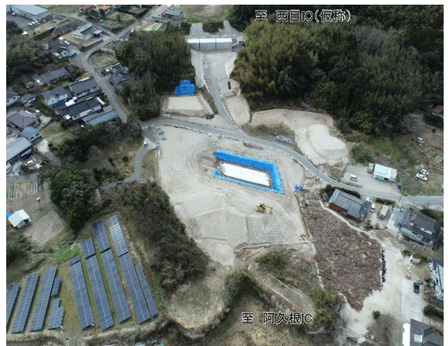
工 事 状 況 床掘完了後、基礎コンクリート養生中です。
