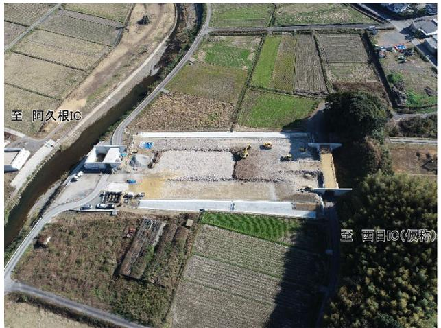
工事状況 (土橋地区) 現在、路体盛土工 (ICT) 及び法面整形工を施工中。
