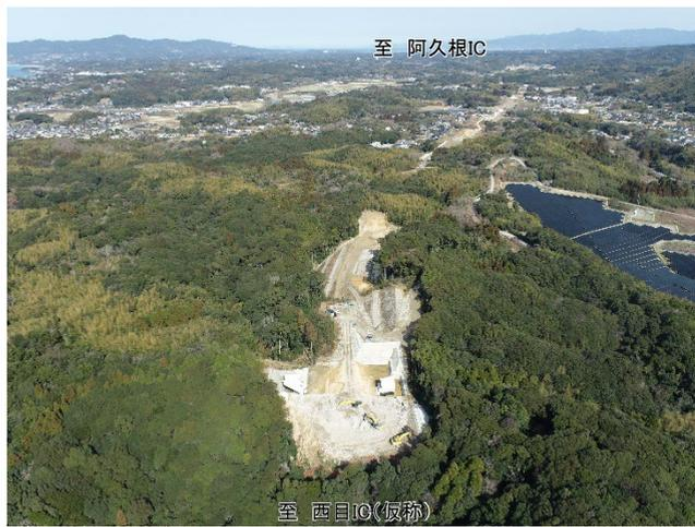
工事状況 (大谷地区) 現在、中硬岩掘削・運搬及び (ICT)法面整形工を施工中。
