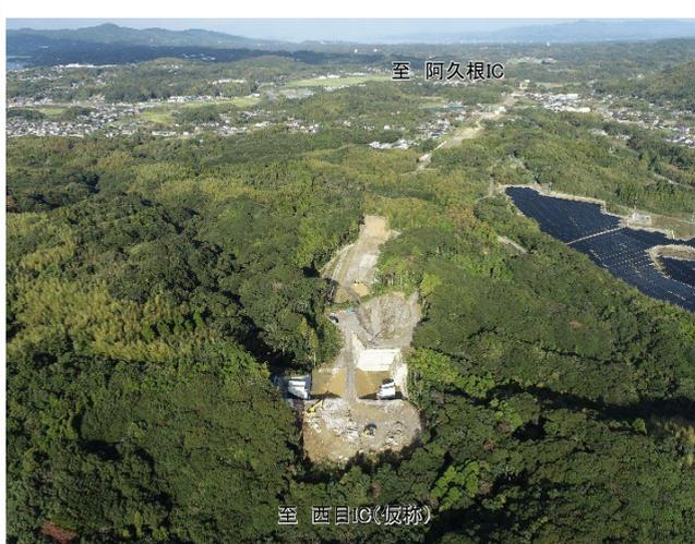
工事状況 (大谷地区) 現在、軟岩 (ICT) 及び中硬岩掘削、並びに小段排水工施工中。
