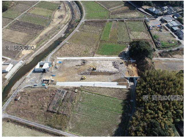
工事状況 (土橋地区) 現在、路体盛土工 (ICT) 及び ブロック積工を施工中。
