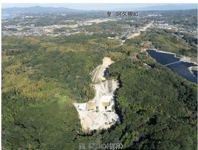
工事状況 (大谷地区) 現在、軟岩 (ICT) 及び中硬岩掘削、法面整形工を施工中。
