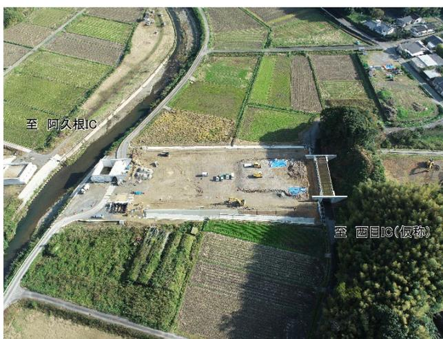
工事状況 (土橋地区) 現在、路体盛土工 (ICT) 及び小段排水工・ブロック積工施工中。
