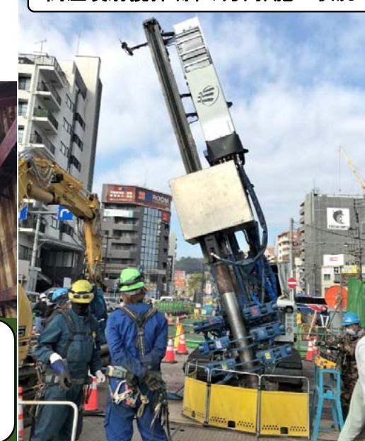
高圧噴射攪拌(斜め方向)施工状況
