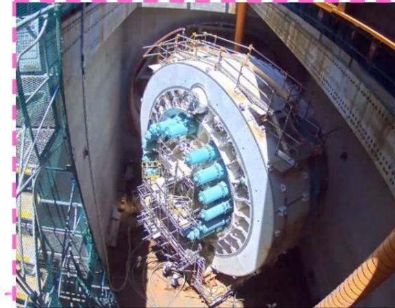
立坑内で組み立て中のシールドマシンを90°回転させる作業の状況写真
