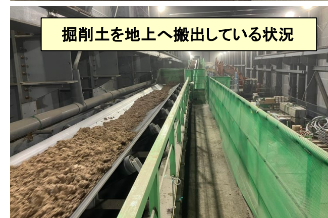
トンネル坑内の状況
