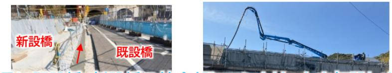
2025年2月に既設橋・新設橋の接合部にコンクリートを打設しました。
