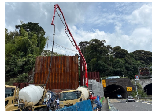
コンクリート打設作業状況(全景)
