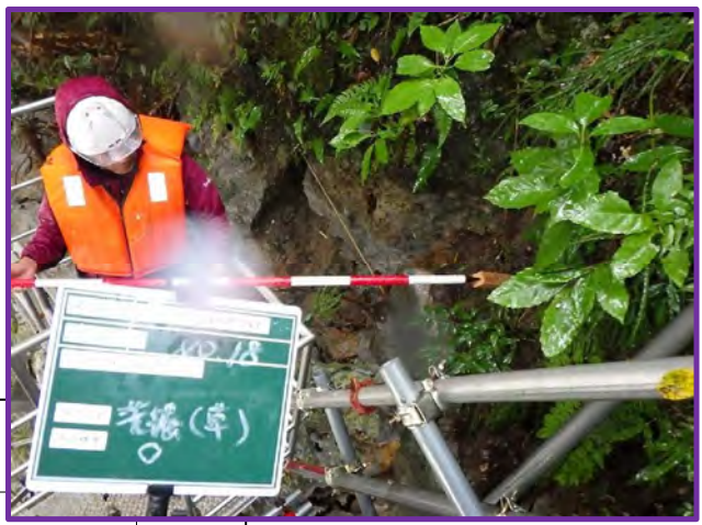
痕跡水位調査状況
