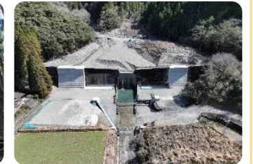
砂防えん堤の整備
