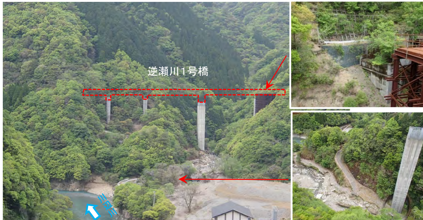
② 付替村道(逆瀬川1号橋)
