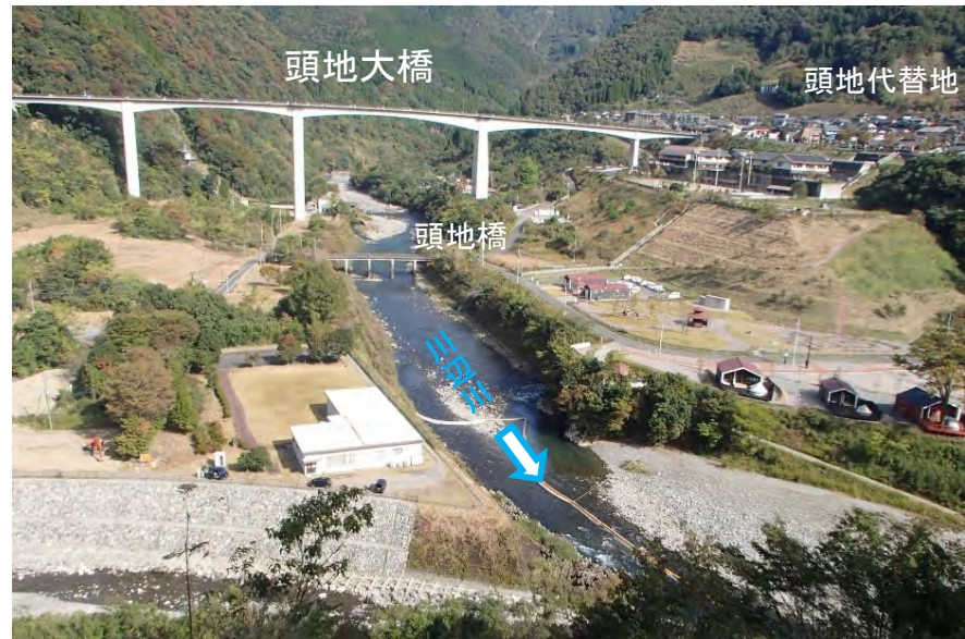
① 付替県道(頭地大橋)
