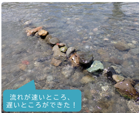
完成した石積み
