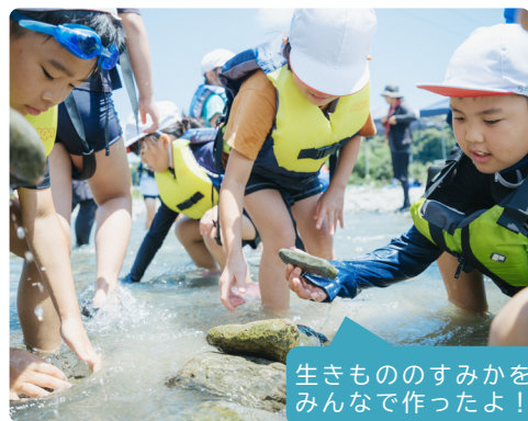
石積み作業の様子
