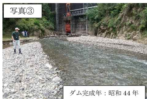
高松ダム（鹿児島県）上流の状況_R4.6.28 時点
