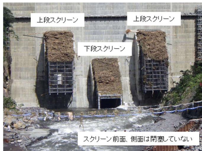
貯水位低下後のスクリーン状況 (R5.7.4 9:30 頃)
