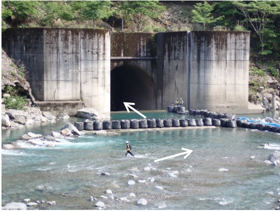
実験 2 回目の状況（大型土のうによる導水）
