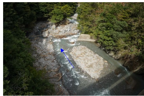
縦木砂防堰堤直下の状況 (令和4年9月29日撮影)
