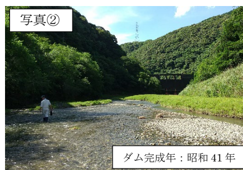
高尾野ダム（鹿児島県）上流の状況_R4.6.28 時点
