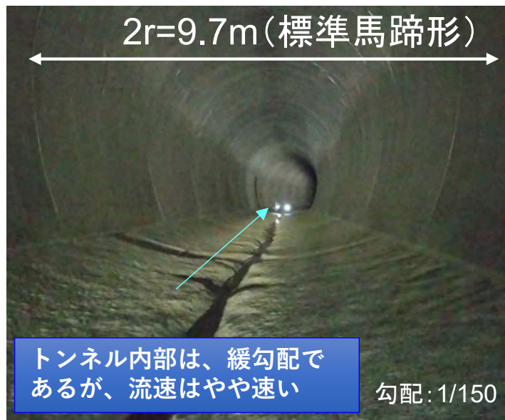
●トンネル内部
