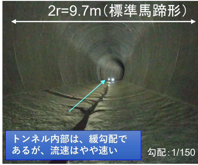
●トンネル内部
