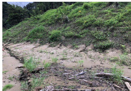
既往流水型ダム(辰巳ダム)の洪水調節後の堆積状況
